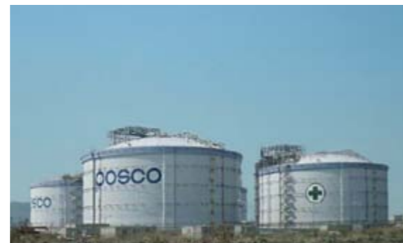
Gwangyang LNG Terminal Tanks (Nos. 3 & 4), Korea
